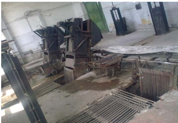
Рис.1. Решетки очистного сооружения г.Ош до реконструкции
